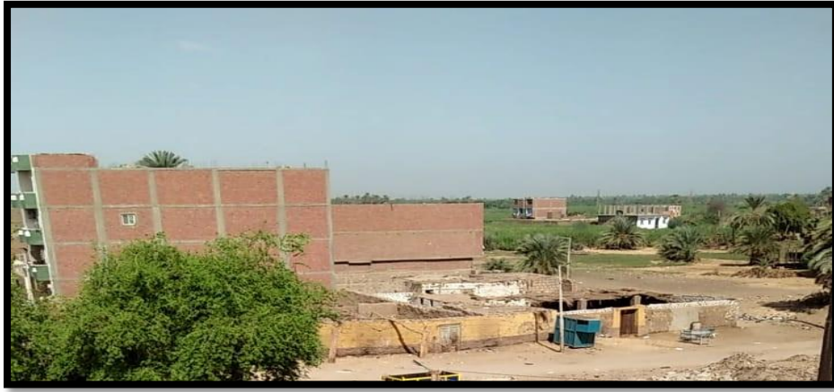
صورة(١) عشوائية إرتفاعات المباني ومواد البناء، البناء على الأراضى الزراعية، نجع العرب، سبتمبر ٢٠٢٢م، اتجاه النظر:الجنوب الغربى
